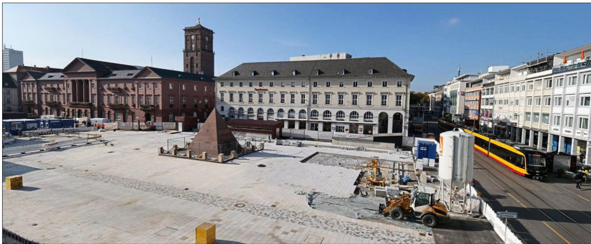
STEIN AN STEIN, die gute Stube der Fächerstadt wird bald fertig sein: Im November wird sich die Lücke bei der Pyramide um die Wasserdüsen (Mitte rechts) schließen und an der Westseite direkt vor dem Café Böckeler wird die Fläche gepflastert, wo die Tische und Stühle verschwunden sind (hinten). Foto: Sandbiller
